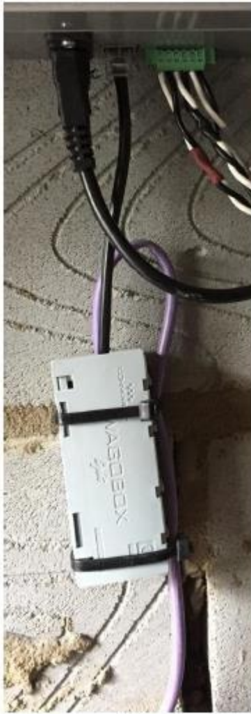
Obrázek 3 – Připojení sériového kabelu k zásuvce RJ45 na rozbočovači
